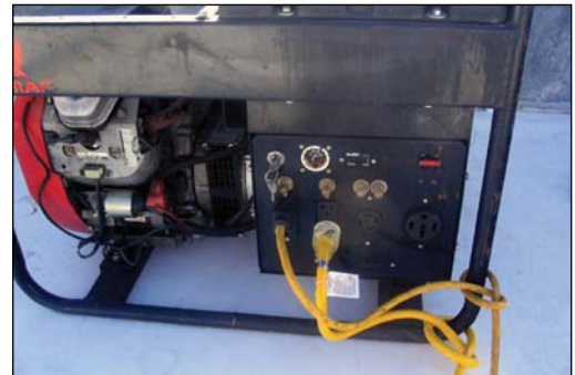
One cord per circuit and per tool
